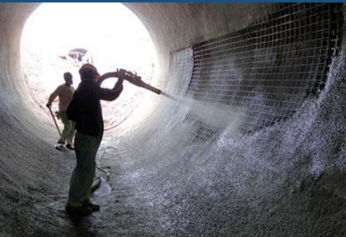
Figura 08 do Parecer - Emboque de túnel em solo
