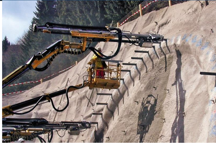
Figura 06 do Parecer - Escavação em solo
