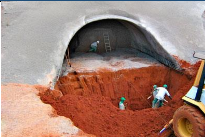
Figura 07 do Parecer - Tratamento com tela e concreto projetado
